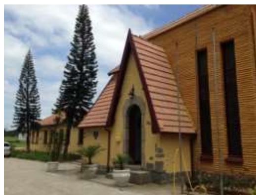
Prédio administrativo depois da pintura.
